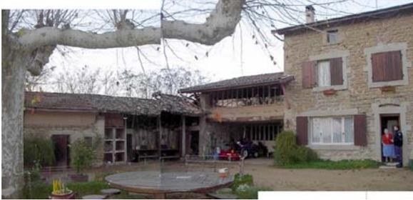
Construction traditionnelle en maçonnerie de pierre (molasse), chaînes d'angle en pierres appareillées
