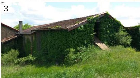
Au Nord ensemble bâti traditionnel en maçonnerie de molasse - encadrement des ouvertures en pierre et brique (pour l'habitation), couvertures 2 pans en tuiles plates rouge. Les dépendances au sud-ouest de l'habitation sont repérées.
