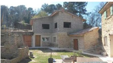
Construction d'origine en maçonnerie de pierre (molasse)
