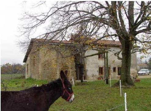
Construction rectangulaire traditionnelle avec maçonnerie en galets roulés
